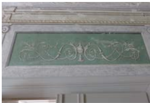
Abb. 8: Wandmalerei oberhalb der Eingangstüre
